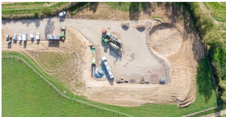
Réalisation des accès des plateformes temporaires dédiées au montage des éoliennes
